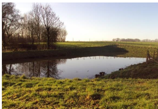
Bassin de rétention amont
