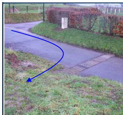
Caillebotis recevant les eaux de la VC
