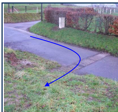
2b-Caillebotis recevant les eaux de la voie communale (route de la Mare)
