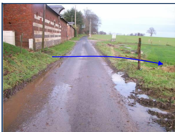
Ouvrage de collecte en amont du talweg principal
