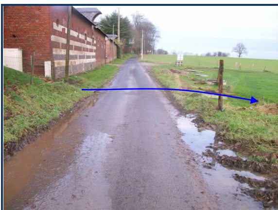
1a - Ouvrage de collecte en amont du talweg principal
